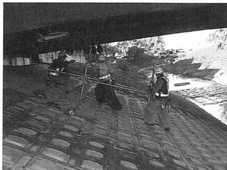
写真8 作業床組立状況
